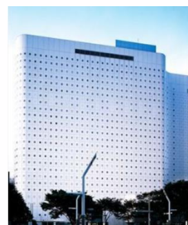
ホテル：新宿ワシントンホテル本館
