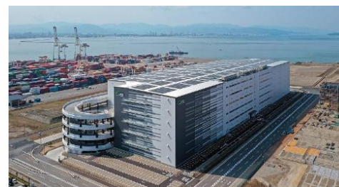
物流施設:T-LOGI 福岡アイランドシティ
